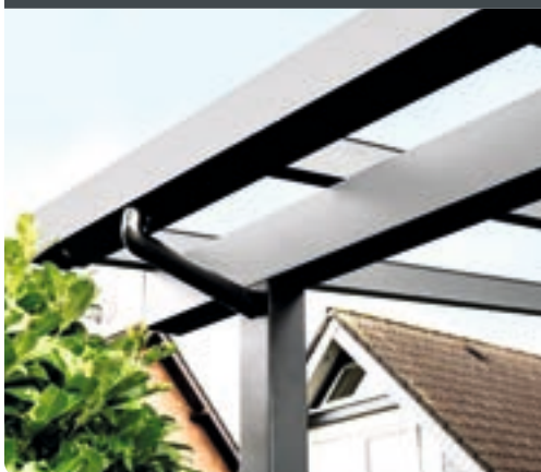
Stützen mit integriertem Ablauf
